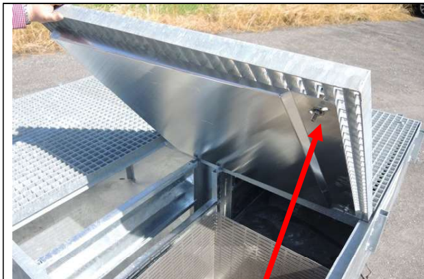
Schloss zum Öffnen des Pumpensumpfs
