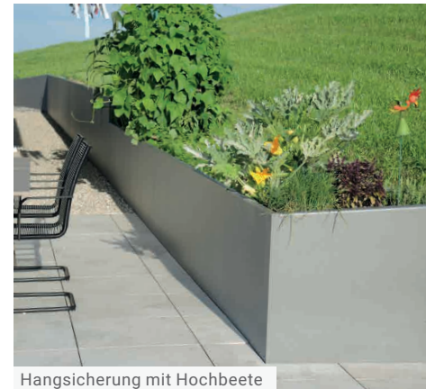
Hangsicherung mit Hochbeete
